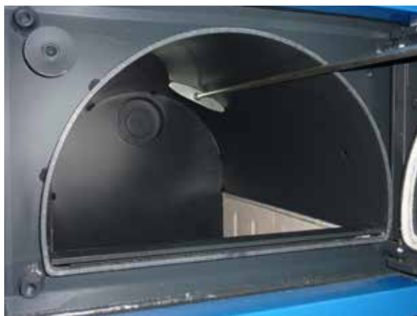
Czyszczenie górnej komory ładowania pogrzebaczem
